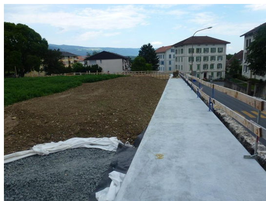
Bétonnage du nouveau chemin de ronde
