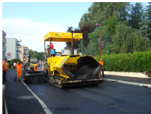
Pose de l'enrobé bitumineux
