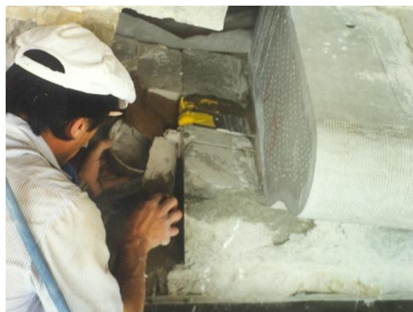
Détail de remplacement du cerclage : nouvelle gaine en inox pour recevoir un couple de tirants.
