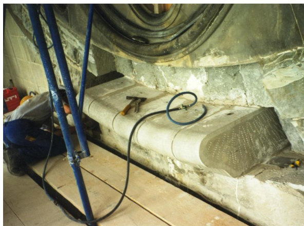
Zone inférieure du cercle de la Rose. Remplacement des Assises jusqu'à la moitié de l'épaisseur des murs en Maçonnerie.
