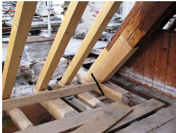
Assainissement de la charpente existante
