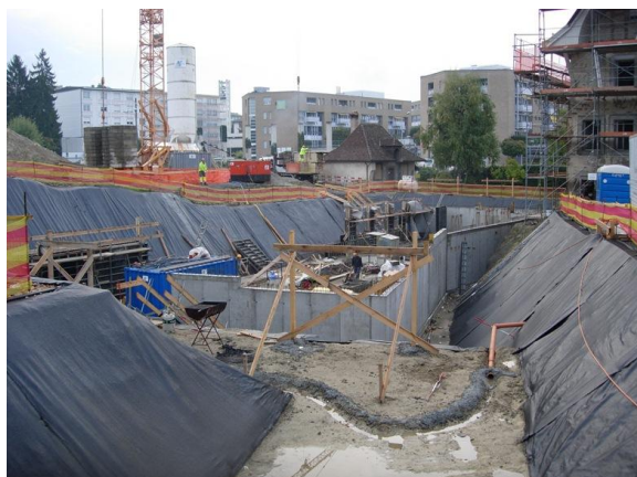
Bétonnage des murs du sous-sol
