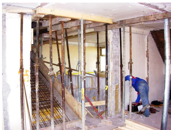
Création de la nouvelle trémie d'escalier
