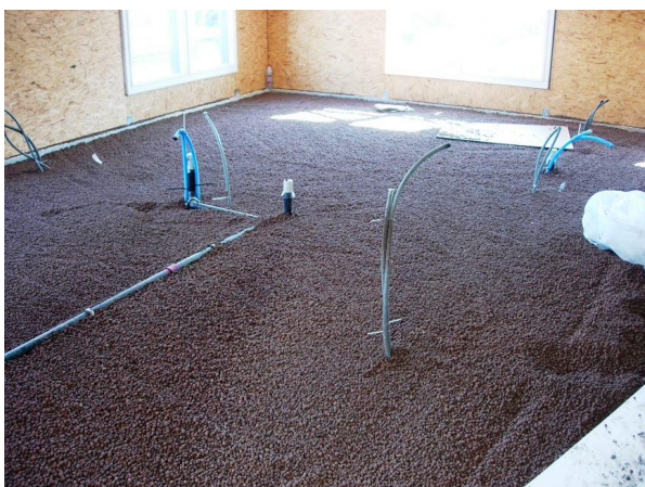
Chape allégée avec des billes d'argiles expansées
