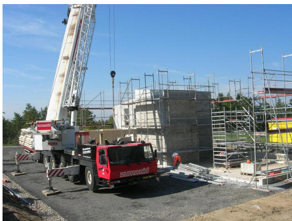
Radier et dalle béton / Murs en briques
