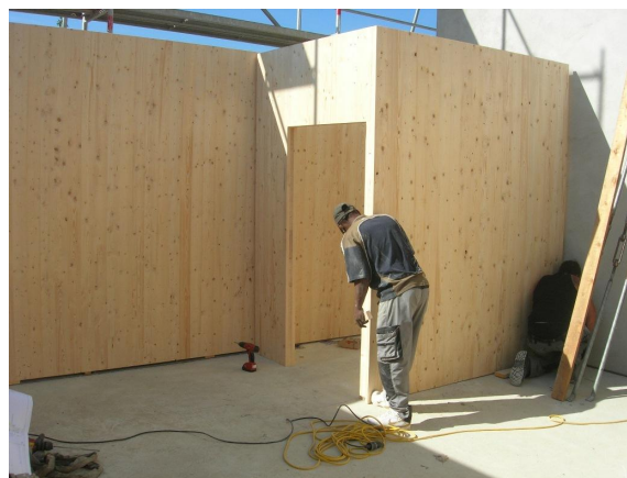
Montage des cloisons en bois
