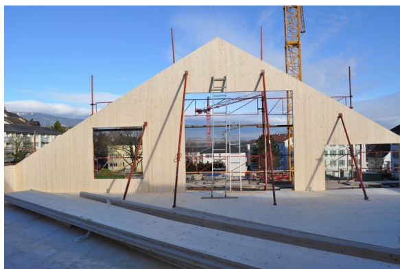
Panneau contrecollé supportant la toiture
