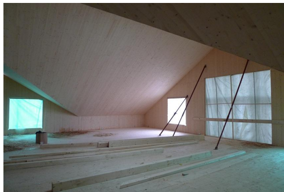
Dalle, parois et toiture en bois
