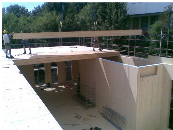
Pose de la toiture
