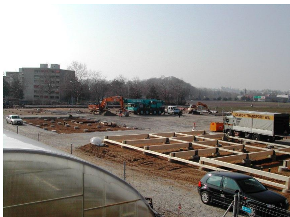
Fondations : pilotis en tube ciment remplis de B.A.
