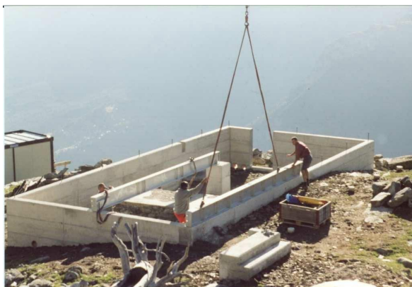
Fondation en béton armé / Poutres métalliques
