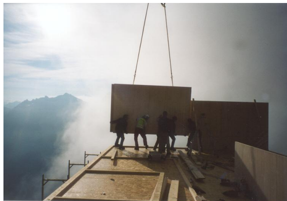
Mise en place des cloisons bois à l'aide de l'hélicoptère
