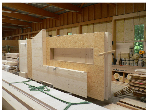
Préfabrication des caissons / parois / de la toiture
