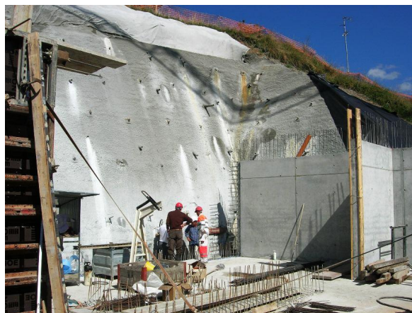
Bétonnage du sous-sol
