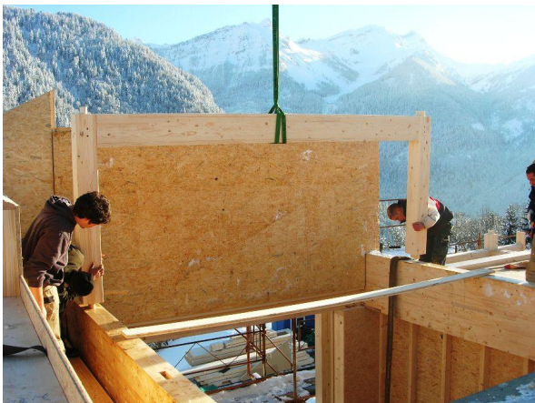
Montage de la charpente
