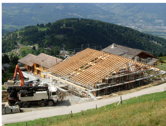
Pose de la charpente
