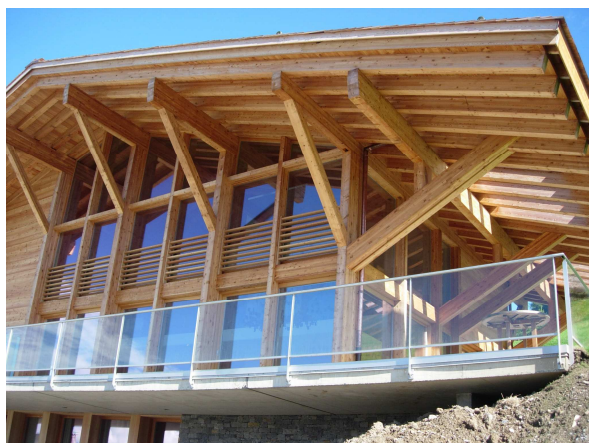
Reprise de l'avant toit triangulé
