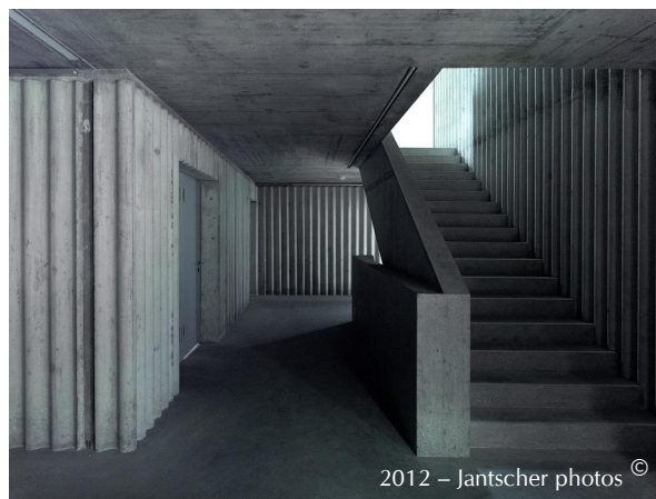
Rendu intérieur des coffrages texturés
