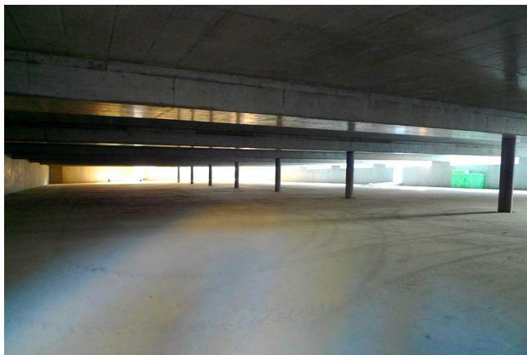
Portée de 34 mètres avec un appui central
