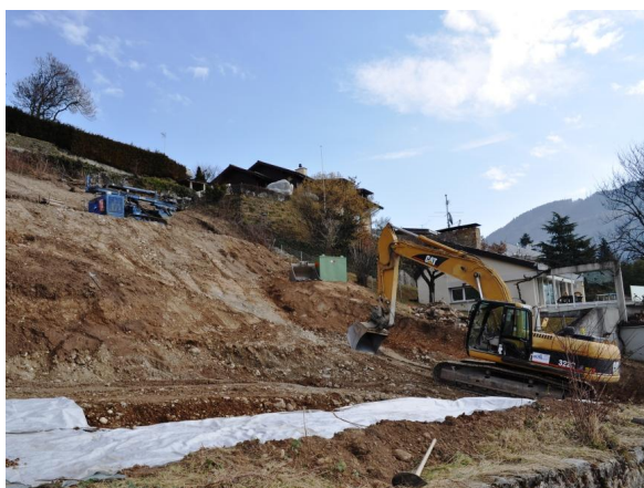
Terrassement, aménagement d'une piste de chantier
