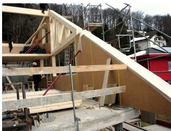
Montage de la charpente
