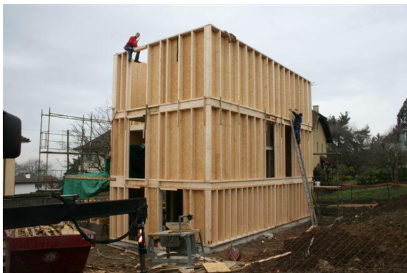
Montage de la charpente
